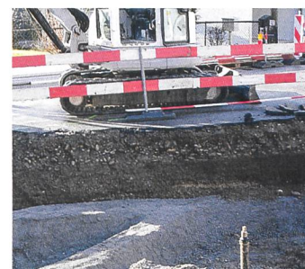
71 Roggwil, Kilchweg, Oberer Freiburgweg
