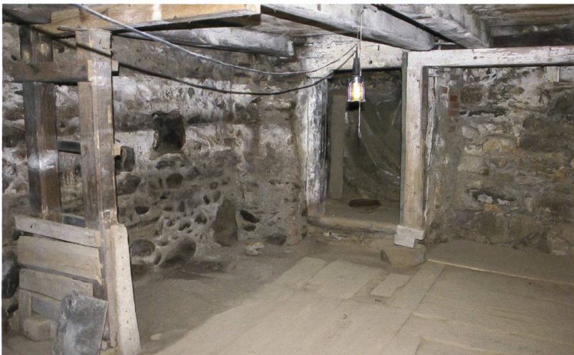
31 Thun, Schorenstrasse 40. Blick in den hinteren, südöstlichen Bereich vom Keller (Raum 1) auf den in Phase 4 geschaffenen Durchgang (127) zum älteren Keller (Raum 2). Dessen Aussenwand (47) schliesst links neben dem Türständer noch bündig mit dem QB Ia ab. Zustand 2020.
