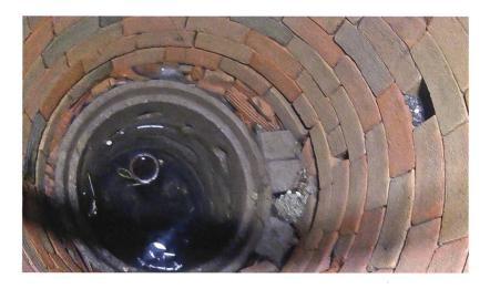
34 Thun, Schorenstrasse 40. In der Phase 4 musste die Brunnenröhre (31) mit Backsteinen (153) vertieft werden. Im Verband der Backsteine beliess man Trittlöcher für eine Revision der Brunnensoble. In Phase 10 wurde eine erneute Abtiefung notwendig. Zwei handelsübliche, mit Löchern versehenene Betonringe (154) erfüllten diesen Zweck. Im Zentrum ist das gusseiserne Rohr einer Sodpumpe zu sehen, die wahrscheinlich schon in der Phase 8 installiert worden ist.
