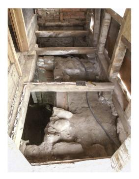
29 Thun, Schorenstrasse 40. Die Sondage V legte die Situation unter dem Fussboden des Raumes 4 frei. Die Backsteinmauer (117) steht auf der alten Kellertreppe (122) aus der Phase 3. Der dazugehörige Keller (Raum 2) reicht bis zum dritten Bodenbalken. Links zeigt sich das Flickmauerwerk (46) aus Phase 5. Von der Bildmitte bis zum Vordergrund zieht sich die versetzte Südostmauer (45) des Kellers (Raum 1). Zustand 2020.
