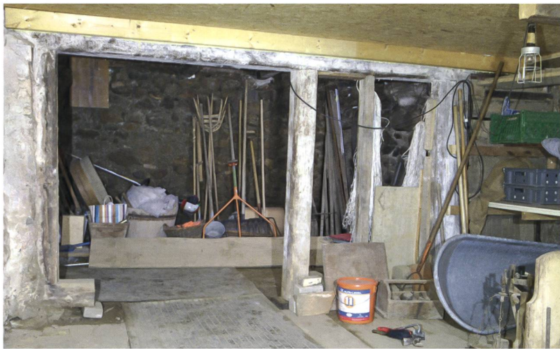
30 Thun, Schorenstrasse 40. Im Hintergrund von Raum 1 (oben links) deutet die Unterkante eines verschlossenen Kellerfensters die ungefähre Tiefe der ursprünglichen Sockelmauer (21) an. Alle tiefer gehenden Wandflächen entstanden in Phase 5 durch Unterfangung. Zustand 2018.
