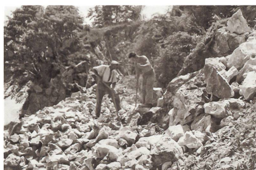
4 a-d Gléresse, Schützenfluh. Travaux d'évacuation des déblais et du ravalement des parois rocheuses après l'opération de dynamitage en 1936 dans le cadre de la construction du Rebenweg.
