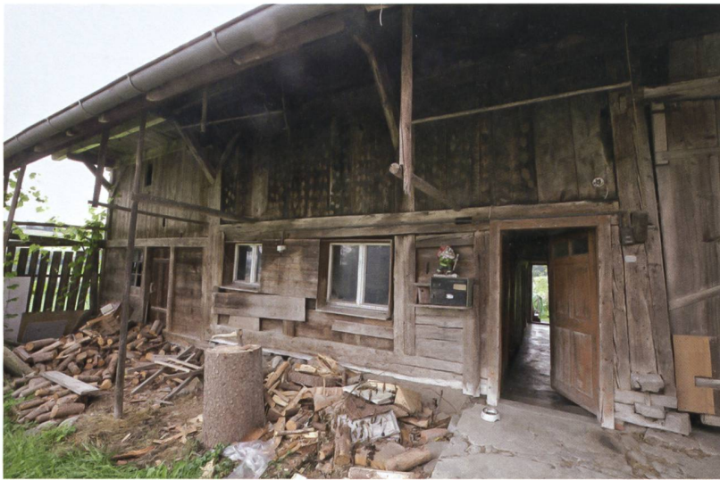
5 Schwarzenburg, Albigen Mischleren 96. Blick an die Nordfassade. Zentral im Bild die zweigeschossig abgebundene Fassade der ältesten Hauskonstruktion, unten stark durch Fenster und vorgegelagerte Bretter überprägt, oben die stehenden, mit Beilhieben verzierten Bohlen.
