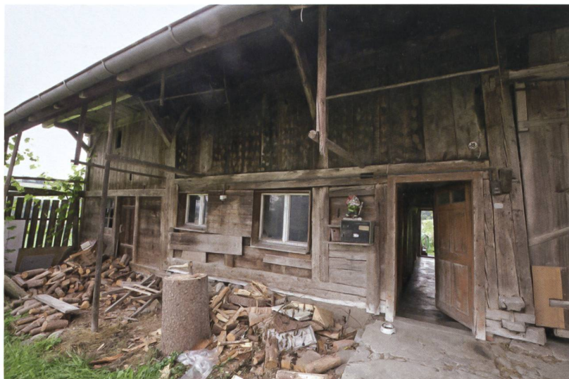
5 Schwarzenburg, Alb-ligen Mischleren 96. Blick an die Nordfassade. Zentral im Bild die zweigeschossig abgebundene Fassade der ältesten Hauskonstruktion, unten stark durch Fenster und vorgehängte Bretter überprägt, oben die stehenden, mit Beilhieben verzierten Bohlen.
