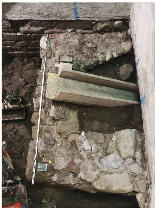
5 Bern, Gerechtigkeitsgasse 21. Blick auf das Fundament des älteren Treppenturms (19) (Abb. 2) mit der Unterlage für die erste Wendeltreppentstufe. Blick nach Westen.
