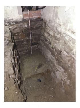
darüber setzt das aufgehende Mauerwerk an. Dieses besteht aus im Vergleich zum Gebäude auf der Westseite insgesamt deutlich grösseren Sandsteinformaten, die vom Mauerbild her ins 14. Jahrhundert datiert werden können. Beobachtungen am Fundament lassen den Schluss zu, dass die Mauer frei in der Baugrube hochgezogen wurde. Dies und die beträchtliche Höhe
