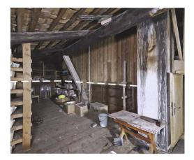
9 Reichenbach, Kientalstrasse 12. Raum R17. Durch das Anheben der Decke beim Einbau des Ladens im Stubengeschoss konnte R17a nicht mehr als Kammer genutzt werden. Der Boden lag neu direkt unter den Fenstern, die im hinteren Bildteil noch zu erkennen sind. Die Decke (weisse Striche) wurde entfernt. Blick nach Südosten.
