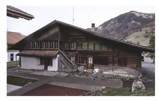
10 Reichenbach, Kientalstrasse 12. Ostfassade. Der steinerne Sockel kragt aus dem Grundriss vor und ist mit einem Pultdach geschützt. Im Gadengeschoss wurden im 18./19. Jahrhundert die beiden Gaden eingebaut. Durch den Einbau des Ladens und die Erweiterung nach Norden erfolgten massive Veränderungen in der Nordostecke des Hauses. Die Auflassung der offenen Rauchküche führte zu einem neuen Raum, der über eine Treppe erschlossen wurde (linke Hausseite). Blick nach Westen.
