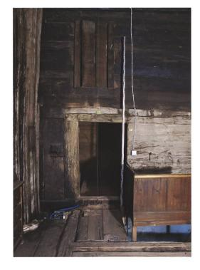
8 Kandergrund, Ausserrüteni 121. Nordwand der Rauchküche auf Höhe des Gadengeschosses. Im Boden sind die Balken der Galerie erhalten. Hinter dem Kamin links befindet sich die Originaltüre, welche verschlossen und an die heutige Stelle verschoben wurde. Blick nach Norden.
