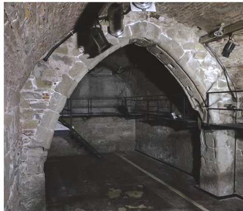
1 Bern, Kramgasse 4. Der Gurtbogen von Süden. Die ungleichmässig breiten Fugen geben bereits einen Hinweis darauf, dass der Bogen nicht original an dieser Stelle sitzt, sondern wiederverwendet und ohne grosse Sorgfalt aufgemauert wurde.
