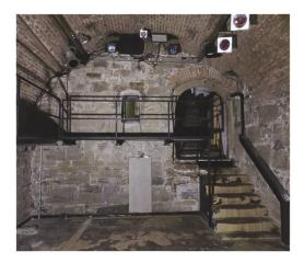
schossen auf dieser Linie aufliegenden Lasten, das heisst die Ost-West-verlaufenden Binnenwände und die Kachelöfen statisch zu sichern. Derartige Gurtbögen gibt es in vielen Kellern Berns, nur sind sie meist gleich alt wie eine der Bauphasen des Kellers, wurden also beim Bau oder der Erweiterung eines Kellers neu geschaffen und waren keine wiederverwendeten Bauelemente (sogenannte Spolien).
