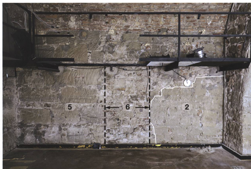
4 Bern, Kramgasse 4. Ostwand. Mauer (2) und der Wundverband der abgebrochenen Mauer (6) der Bauphase 1; Mauer (5) der Bauphase 3. Darüber das Backsteintonnengewölbe.
