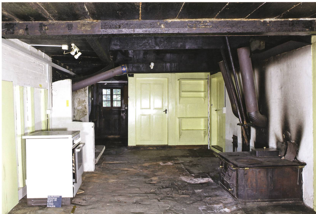
Abb. 20: Rüscheegg Sangern 183. Blick nach Norden in die 1859 modernisierte Küche (Raum 6). Von der ursprünglichen Rauchküche verblieb nur ein Teil der Trennwand (110) zum benachbarten Schmalviehstall (Raum 8). Von den Massnahmen der Bauphase II haben sich nur ein sandsteiner Herd (103), die Raumdecke und die Rauchhütte (111) erhalten. Das übrige Inventar stammt aus der Bauphase III.
