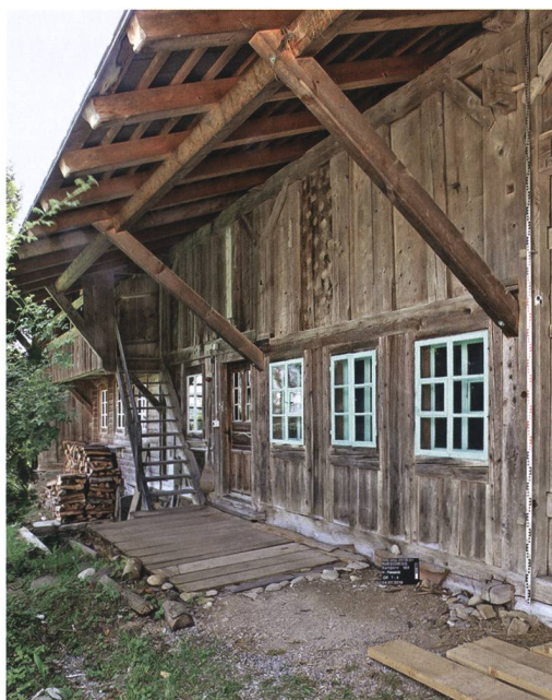
Abb. 10: Rüschegg Sangern 183. Wohntrakt der nördlichen Haushälfte zwischen dem zweiten und vierten Querbund. Die Nebestube im Vordergrund (Raum 7, Abb. 13) ersetzte einen Schmalviehstall. An den Bundachsenschnittpunkten zeigen sich auf Schwellbalkenhöhe die alten Zapfenschlösser. Gerüst und Gefüge im Dachgeschoss sind überwiegend original. An den Ständerbohlenwänden finden sich die regionaltypischen, tupfenartigen Verzierungen. Blick nach Südosten.
