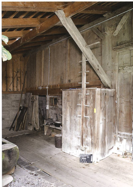
Abb. 17: Rüscheegg Sängern 183. Südliche Haus- hälfte zwischen dem fünften und sechsten Querbund. Blick in den Brunnenschopf mit dem Tenntor (95) und dem benachbarten Abort. Dahinter die Südwand (99) des Grossviehstalles. Auch wenn fast die gesamte Situation in jün- gerer Zeit überformt wurde, entspricht sie dem originalen Zustand. Blick nach Nordwesten.
