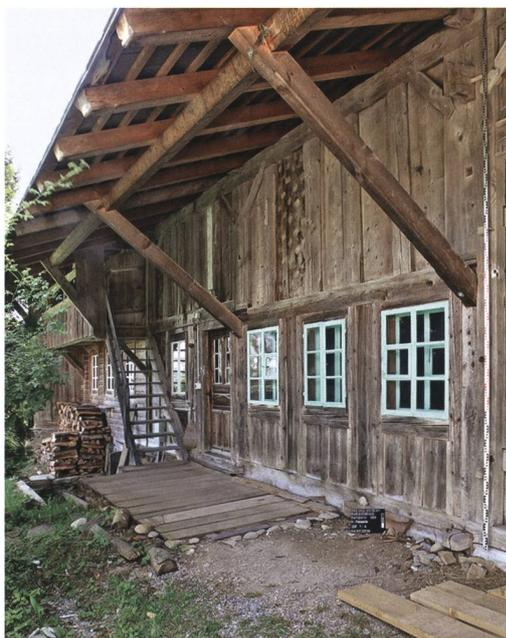
nicht nur auf die Mittelpfetten (10, 22) gekämmt, sondern an diesen Punkten zusätzlich firstlängs und firstquers mit Kopfbändern gesichert. Alle Pfetten fungieren als oberste versteifende Elemente der jeweiligen Längsbünde. Allgemein sind Haus- und Dachgerüst bei diesen Bauwerken so eng aufeinander bezogen, dass sie sich konstruktiv nicht voneinander trennen lassen.
