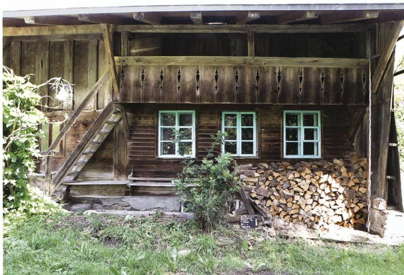
Norden und Süden öffneten sich beide Räume zu den Vordachlauben (48, 66) (Abb. 15). Diese sogenannten Tröcknelauben waren ursprünglich nur von den Gaden her zu betreten. Ihre Erschliessung mittels Aussentreppen wurde erst später angefügt.
