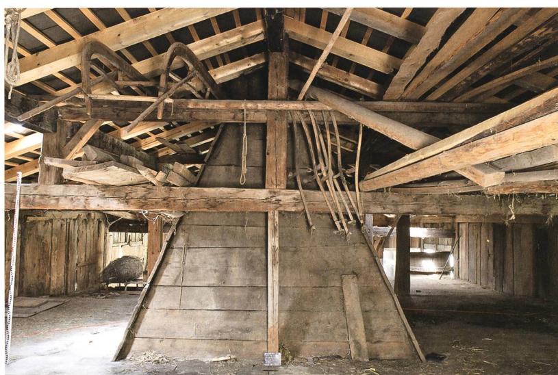
Abb. 21: Rüscheegg Sangern 183. Die hölzerne Rauchhütte (111) wurde 1859 erstellt. Für die Verankerung dieser Konstruktion mussten alle inneren Pfettenständer unterhalb des dritten Ankerbalkens (9) entfernt werden. Damit dieses Langholz die Dachlast nicht frei bis zu den Traufseiten ableiten musste, fügte man einen Angstständer ein. Blick nach Westen.
