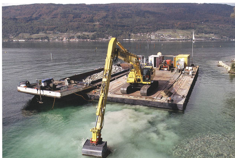
Abb. 5: Der Langarmbagger bringt von einem grossen Arbeitsponton aus die Kiesschüttung ein. Aufnahme 9. Oktober 2020.
