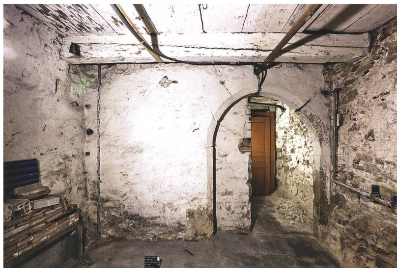
Fig. 5 : La Neuveville, rue du Collège 5. Rez-de-chaussée. Porte de cave (pos. 36) à encadrement en plein cintre orné d'un large chanfrein terminé par un congé oblique. Elle serait associée à un réaménagement daté de 1489. Vue en direction de l'est.
