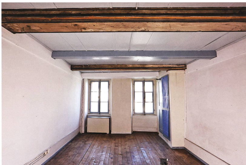
Fig. 6 : La Neuveville, rue du Collège 5. Les solives du plafond de la pièce 16, au 2 e étage, étaient moulurées et se rapportaient à une phase de transformation ou de rehaussement du bâtiment datée de 1507. Le plafond fut renforcé ultérieurement par des solives supplémentaires. Vue vers l'est.
