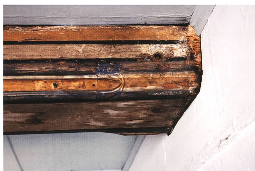
Fig. 6 : La Neuveville, rue du Collège 5. Les solives du plafond de la pièce 16, au 2 e étage, étaient moulurées et se rapportaient à une phase de transformation ou de rehaussement du bâtiment datée de 1507. Le plafond fut renforcé ultérieurement par des solives supplémentaires. Vue vers l'est.
