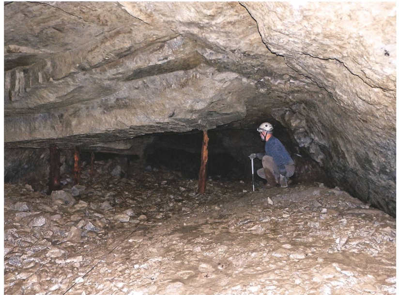
Abb. 2: Guttannen, Zinggenstock. Die Decke stützende Arvenbalken, von welchen Proben für die dendrochronologische Untersuchung entnommen wurden.
