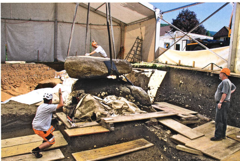
Abb. 10: Oberbipp, Steingasse. Der Fahrzeugkran hebt die tonnenschwere Deckplatte vorsichtig von der Anlage.
