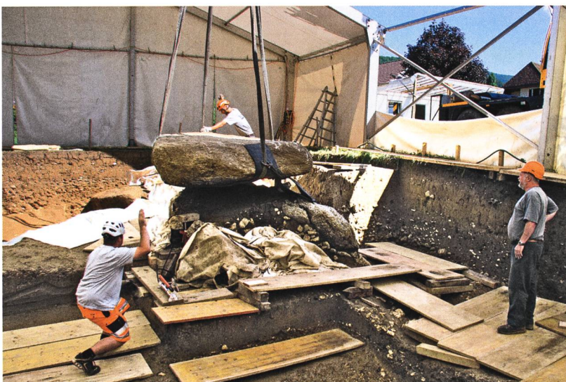
Abb. 10: Oberbipp, Steingasse. Der Fahrzeugkran hebt die tonnenschwere Deckplatte vorsichtig von der Anlage.
