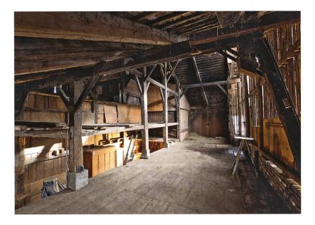
Fig. 3: Valbirse, Bévilard, Les Vannes 15. Dans la grange, on remarque la solide charpente sur poteaux et, à droite, le voligeage formée de perches en rangs serrés qui autrefois portait la couverture de bardeaux. Vue vers le sud-est.
