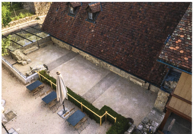
Abb. 3: Twann-Tüscherz, St. Petersinsel. Neuer Bodenbelag mit Markierung der Vierung. Über den Mauerresten des nördlichen Querschiffs erhebt sich ein Schutzdach aus Metallträgern und Plexiglas. Blick nach Nordosten.
