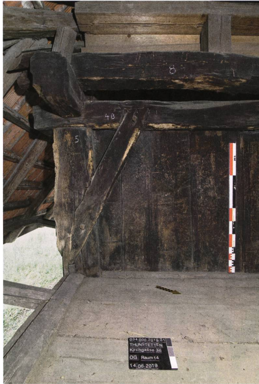
Abb. 7: Thunstetten, Kirchgasse 36. Kopfbereich des aus Eichenbalken gezimmerten Hochständergerüsts der Zeit um 1480 an der Nordostecke des Wohnteils. Das verblattete Kopfband aus Nadelholz stammt vom Bau des Taunerhauses um 1753. Blick von der Tenne nach Süden.
