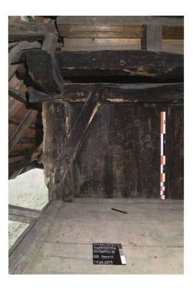
Abb. 7: Thunstetten, Kirchgasse 36. Kopfbereich des aus Eichenbalken gezimmerten Hochständergerüstes der Zeit um 1480 an der Nordostecke des Wohnteils. Das verblattete Kopfband aus Nadelholz stammt vom Bau des Taunerhauses um 1753. Blick von der Tenne nach Süden.
