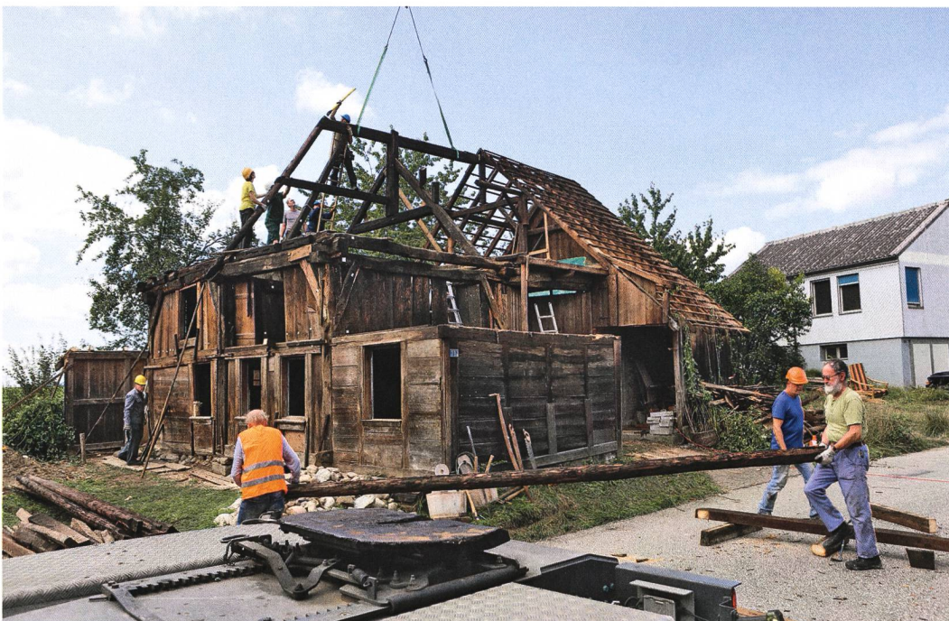
Abb. 5: Thunstetten, Kirchgasse 36: Das Taunerhaus während des Abbaus durch Freiwillige der Initiative für ein Aargauer Freilichtmuseum im August 2019. Blick von der Kirchgasse nach Nordwesten.
