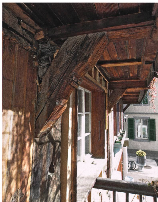
Abb. 6: Steffisburg, Schulgässli 26. Profilierter Bug der unteren Frontlaube vermutlich des Ursprungsbaus von 1569. Sie wurde beim Stubenumbau im 17. Jahrhundert neu an der jetzigen Stelle eingebaut.
