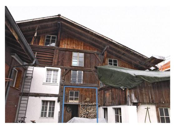
von Bauernhäusern des sogenannten Frutigtyps. Östlich des Mittelkorridors haben sich auch ältere Baureste erhalten. Die Nebenstube im Erdgeschoss ist als einstöckiges Unterbaugerüst in Ständer-Bohlen-Bauweise konstruiert. Heute entspricht der Zustand nicht mehr dem des 16. Jahrhunderts. Sie war im Laufe des 17. bis 20. Jahrhunderts mehrfach umgebaut worden. Auch die östlich angrenzende Wohn-
