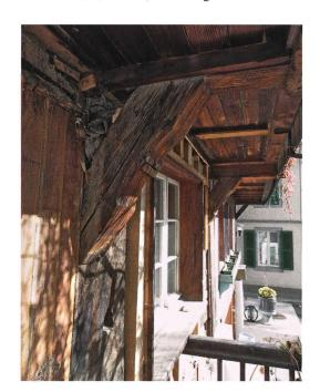
Abb. 6: Steffisburg, Schulgässli 26. Profilierter Bug der unteren Frontlaube vermutlich des Ursprungsbaus von 1569. Sie wurde beim Stubenumbau im 17. Jahrhundert neu an der jetzigen Stelle eingebaut.
