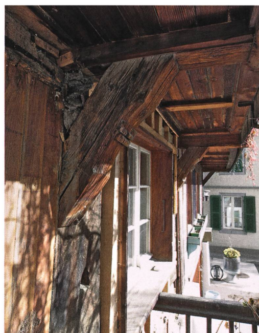
Abb. 6: Steffisburg, Schulgässli 26. Profiliertes Bug der unteren Frontlaube vermutlich des Ursprungsbaus von 1569. Sie wurde beim Stubenumbau im 17. Jahrhundert neu an der jetzigen Stelle eingebaut.
