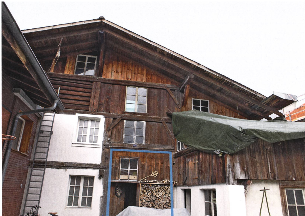
Abb. 3: Steffisburg, Schulgässli 26. Nördliche Rückfassade des westlichen Hausteils. Deutlich abzulesen ist die Struktur des Ursprungsbaus von 1569 mit der nachträglich ausgemauerten zweigeschossigen Rauchküche und dem westlich anschliessenden ehemaligen Hoftor der Ökonomie. Die unteren beiden Geschosse sind als Hochständerbau mit verblatteten Kopfbändern konstruiert.
