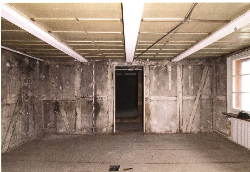
Abb. 8: Steffisburg, Schulgässli 26. Wohn- stube im Erdgeschoss. Entstanden ist sie um 1841/42 beim Einbau der Etagenwohnungen in den ehemaligen seitlichen Ökonomie- teil. Charakter- istisch ist das Riegel- fachwerk mit wandhohen Streben. Blick nach Osten mit der Türe zum Korridor.
