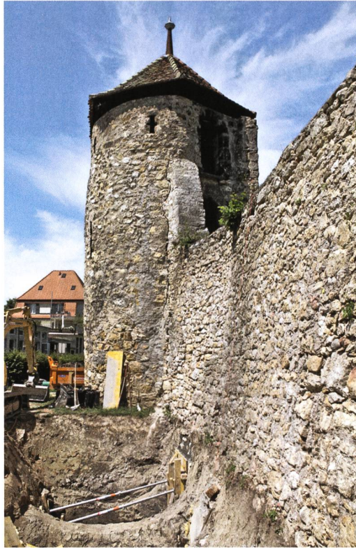
Abb. 5: Nidau, Ziegelhütenturm. Sondierungen zur Unterfangung der einsturzbedrohten mittelalterlichen Stadtmauer am Ziegelhütenturm an der Südwestecke der ehemaligen Altstadt. Blick nach Westen auf den Ziegelhütenturm während der Sanierung im Jahr 2017.
