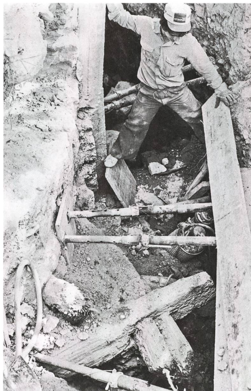
Abb. 4: Nidau, Ziegelhüttenurm. Blick in die Baugrube für die neue Fundamentierung des Eckturms der Stadtbefestigung im Jahr 1980. Der Turm ruhte auf einem Rahmen aus verzapften Eichenholzbalken, die bei der Sanierung 1980 entfernt und durch Presspfahlgründungen und Betonfundamente ersetzt wurden.
