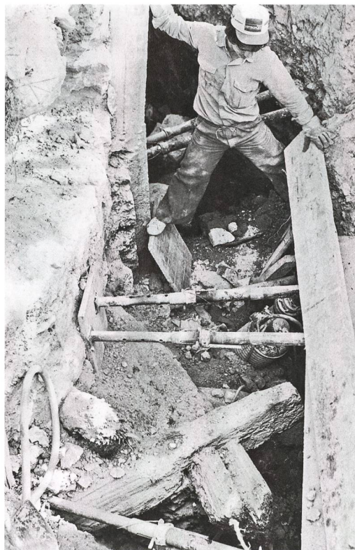
Abb. 4: Nidau, Ziegelhüttenturm. Blick in die Baugrube für die neue Fundamentierung des Eckturms der Stadtbefestigung im Jahr 1980. Der Turm ruhte auf einem Rahmen aus verzapften Eichenholzbalken, die bei der Sanierung 1980 entfernt und durch Presspfahlgründungen und Betonfundamente ersetzt wurden.
