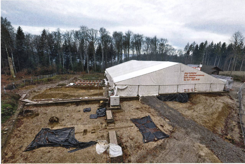
Abb. 2: Kallnach, Challnechwald. Das Grabungsareal der ersten Etappe. Blick nach Norden. Aufnahme vom Dezember 2019.
