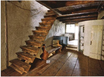
62 La Neuveville, Rue du Collège 5
