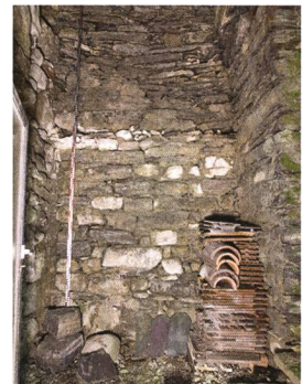
105 Unterseen, Obere Gasse 44
