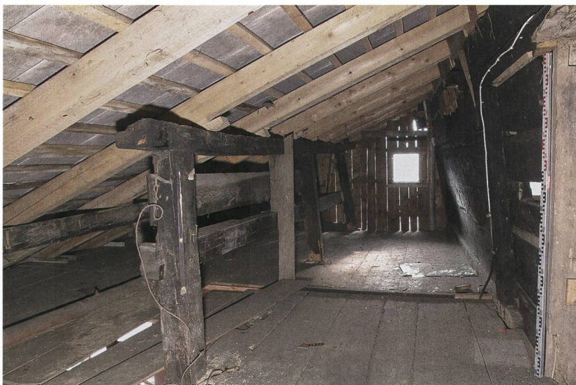
Abb. 19: Stocken-Höfen, Stockentalstrasse 33. Nördlicher, laubenförmiger Speicherraum im Obergeschoss des Wohnhauses mit der Gadenwand und der Konstruktion zum strassenseitigen Kniestock. Blick nach Osten.
