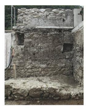
An der Oberkante der heutigen Südmauer ist ein ursprünglicher Mauerabsatz zu erkennen. Darauf dürfte ehemals ein Streichbalken gelegen haben, der am ehesten mit einer im Chor geplanten Decke zu verbinden ist. Vielleicht hat man auch hier den Bauplan geändert und letztlich auf den Einbau der Decke verzichtet, da sie im Verhältnis zum Scheitelpunkt des Chorbogens deutlich zu tief angelegt war.
