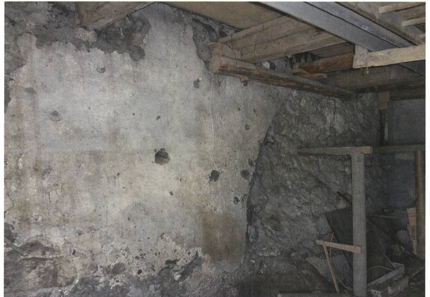
Abb. 2: Stocken-Höfen, Stockentalstrasse 33. Blick in den östlich an das Wohnhaus anschliessenden Ökonomie teil vor den ersten Untersuchungen im September 2012. In der verputzten Chorwand der Kapelle zeichnet sich der nachträglich verschlossene Chorbogen ab. Blick nach Süden.
