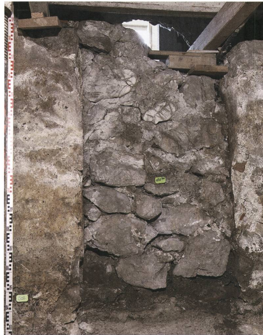
Abb. 6: Stocken-Höfen, Stockentalstrasse 33. Nördliche Chormauer mit dem nachträglich verschlossenen Durchgang zum Turm während der Freilegung im März 2016. Blick nach Nordosten.
