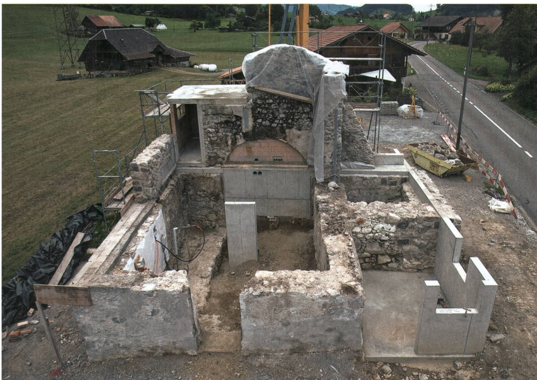
Abb. 10: Stocken-Höfen, Stockentalstrasse 33. Drohnfoto des Gebäudes nach Abbruch aller jüngeren Mauern und den Vorbereitungsarbeiten für das neue Holzhaus im Juli 2018. Vorne im Bild der Chor mit dem verbreiterten Ostfenster, dahinter der bereits neu zugemauerte Chorbogen und rechts der Turmsockel. Blick nach Nordwesten.
