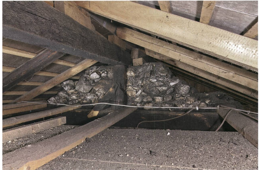
Abb. 21: Stocken-Höfen, Stockentalstrasse 33. Dachspitz mit dem erhaltenen oberen Giebfeld der Chorwand und dem darauf aufgesetzten Dachwerk des ersten Wohngebäudes. Blick nach Westen.
