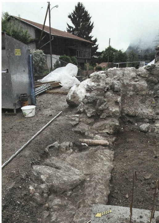
Abb. 9: Stocken-Höfen, Stockentalstrasse 33. Die nördliche Chorschulter und das nördliche Langhausfundament der Kapelle während der Bauarbeiten im Mai 2018. Blick nach Osten.
