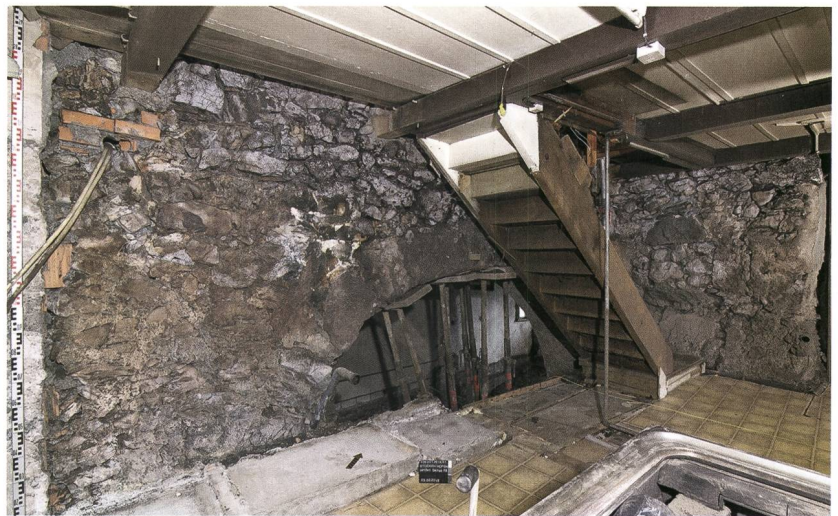
Abb. 7: Stocken-Höfen, Stockentalstrasse 33. Chorbogen und nördliche Chormauer der Kapelle im Erdgeschoss des Wohnhauses nach dem Entfernen der Täfer im Februar 2018. Blick nach Norden.
