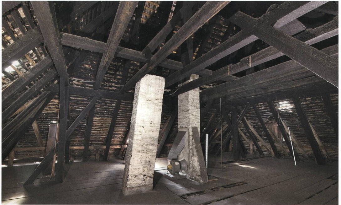
Abb. 5 Steffisburg, Oberdorfstrasse 32. Blick nach Südwesten in das Dachwerk. Aufnahme von 2017.
