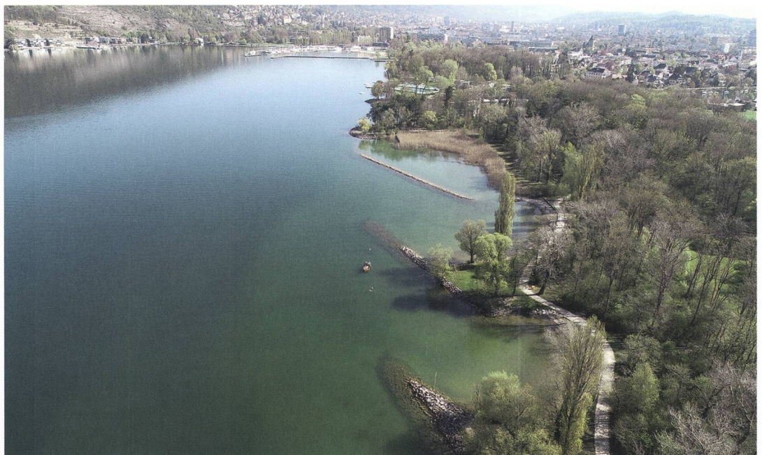
Abb. 1: Ipsach, Erlewäldli. Der Seeuferbereich, an dem bei Tauchuntersuchungen eine neolithische Fundstelle entdeckt wurde. Im Hintergrund gegen Norden das untere Seebecken mit den Städten Biel und Nidau.
