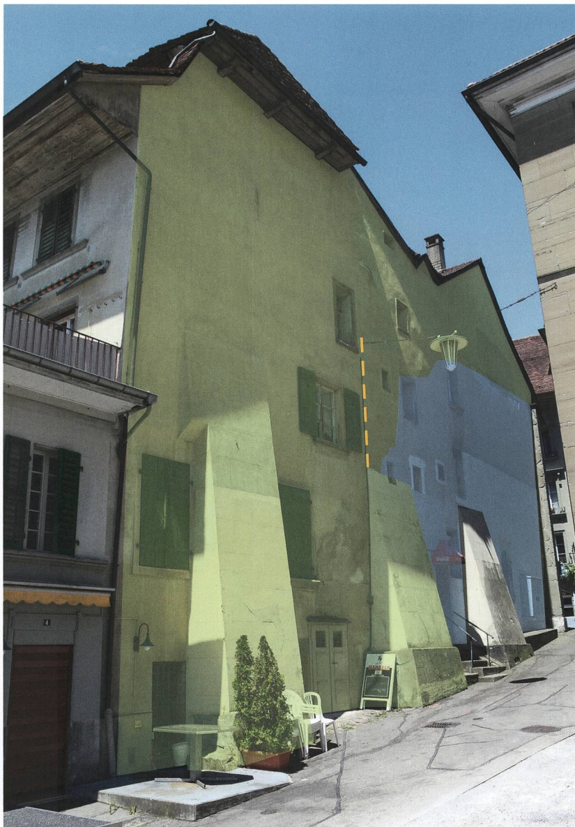
Abb. 4: Burgdorf, Schmiedengasse 1. Ansicht der Ostfassade. Orange gestrichelt: Lage des östlichen Abschlusses der ehemaligen Südfassade nach 1200; blau eingefärbt: die noch in Teilen erhaltene Fassade aus dem frühen 15. Jahrhundert; grün eingefärbt: der Neubau nach dem Brand von 1706.
