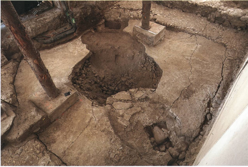
Abb. 6: Burgdorf Schloss. Blick nach Süden auf die Filterzisterne. Gut sichtbar im Vordergrund der Ein- und Überlaufkanal. In der Bildmitte erkennt man den Ausbruch, der bei der Aufgabe der Zisterne herausgerissene Schöpfschacht, sowie die nachgerutschten Kiese und Sande des Filterkörpers.
