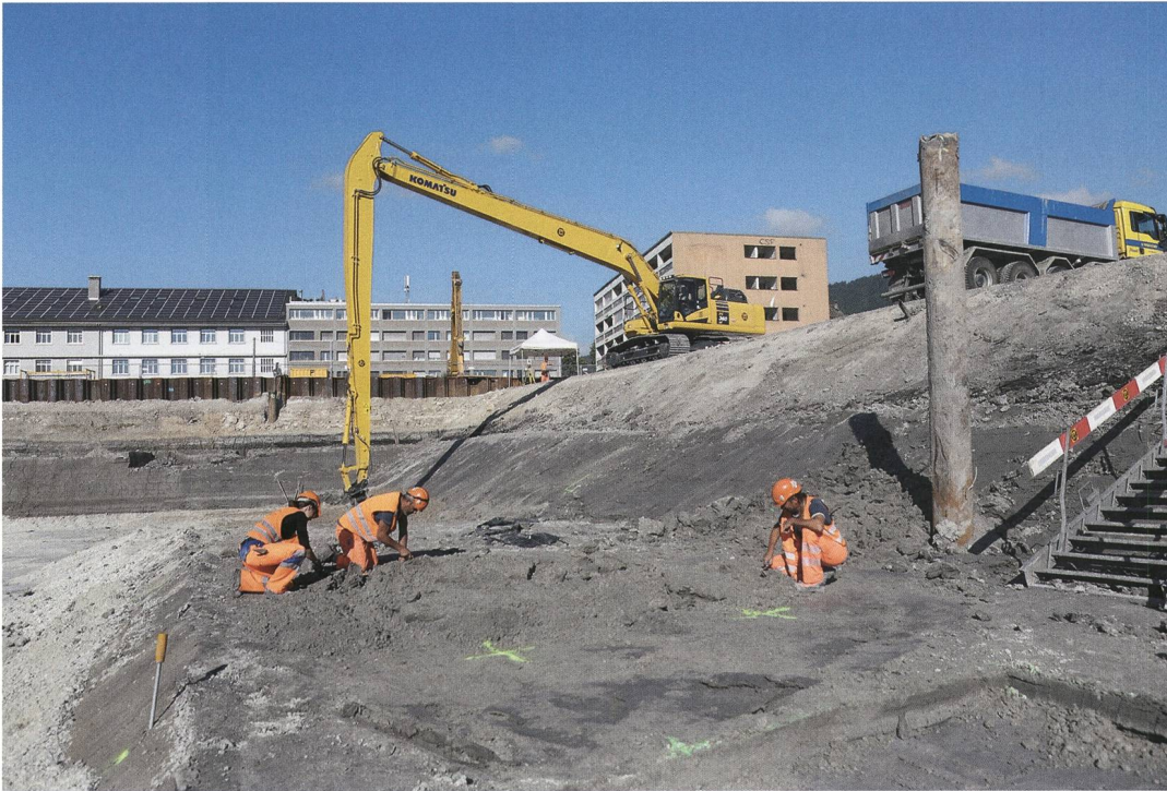
Fig. 2 : Bienne, Campus. Vue vers l'ouest du chantier archéologique. Le périmètre des futures constructions et de la fouille a été étanchéifié par des palplanches, afin de décaper au sec les vestiges, situés à 4,5 m sous le terrain actuel.
