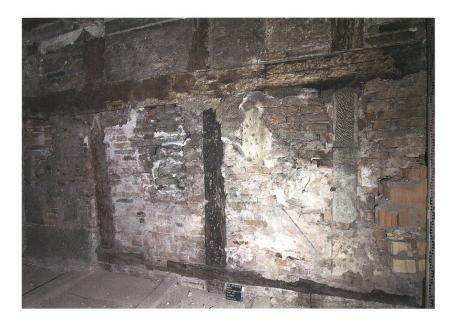
Gassenfassade, angepasst an die neuen Stockwerkhöhen. Diese neuen Böden wurden durch zusätzliche Balken verstärkt, welche auf Winter 1718/19 datiert sind, was stilistisch sehr gut zur Fassade, dem Treppenhaus und der erhaltenen Ausstattung passt.
