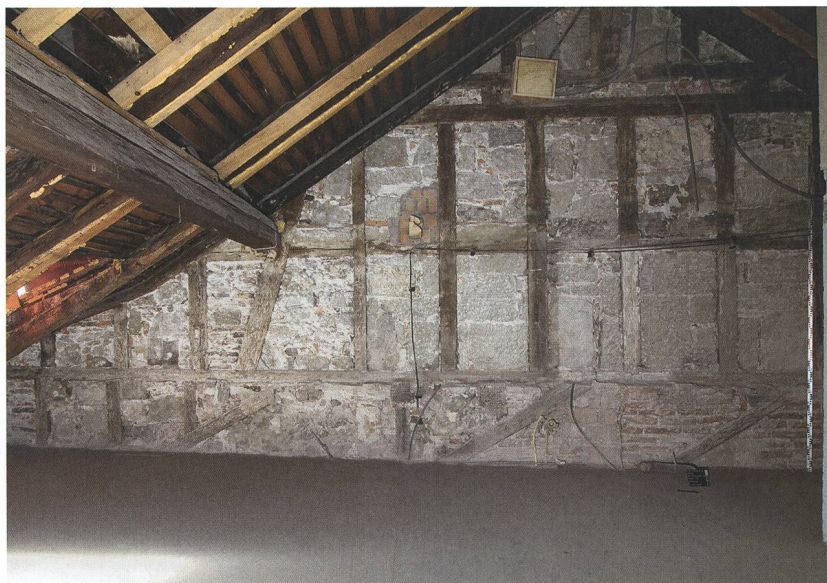
Abb. 5: Bern, Rathausgasse 64. Westbrandmauer im Dachgeschoss mit den eingemauerten Rafen der verschiedenen Dachhöhen, darüber die Aufstockung zum heutigen Dach. Blick nach Westen.
