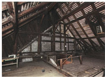
117 Unterseen, Obere Gasse 22/24
