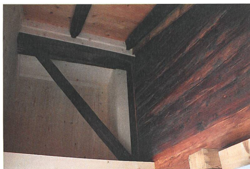
Abb. 7: Zweisimmen, Lusflue-Weg 6. Frühester bekannter Vertreter ohne Heidenkreuz im westlichen Berner Oberland. Aussenansicht des Giebels der Westfassade, heute von jüngerer Laube verdeckt. Schlagjahre 1506/1508.
