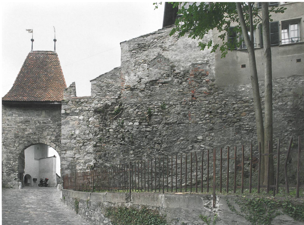
Abb. 1: Thun, Burgitor. Das Burgitor und die Hangstützmauer (N) am östlichen Schlossaufgang vor Beginn der Sanierung 2016. Blick nach Westen.
