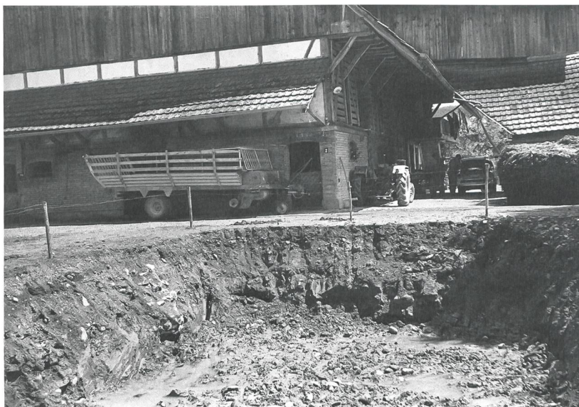
Abb. 4: Krauchthal, Hettiswil, Oele 1–3. Stallteil des Wohnhauses mit der Baugrube für das neue Ökonomiegebäude im Vor- dergrund, 1970. Blick nach Nordosten.
