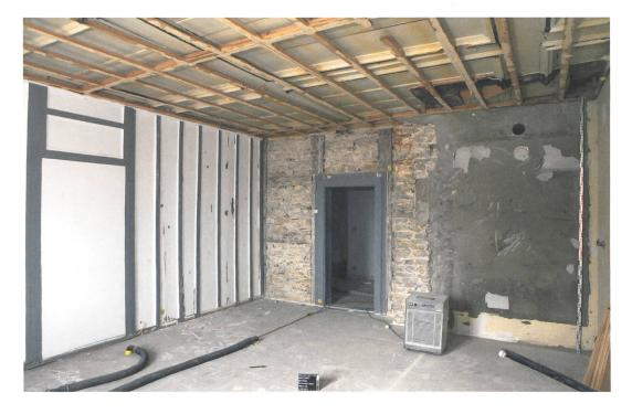
Fig. 7: Saicourt, Bellelay, L'Abbaye 1. 2ème étage: la Salle de justice et son plafond à caissons; à droite, dans le plafond, traces du fourneau rectangulaire aujourd'hui disparu. La paroi en bois, à gauche, est postérieure et date probablement de la seconde moitié du 18e siècle. Vue vers l'est.
