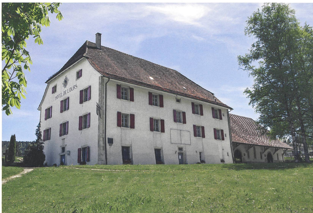
Fig. 1 : Saicourt, Bellelay, L'Abbaye 1. L'imposante bâtisse de l'Hôtel de l'Ours édiflée dès 1697. Vue vers le sud.
