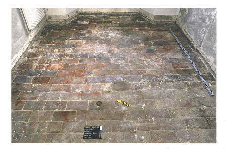
Fig. 4: Saicourt, Bellelay, L'Abbaye 1. 1<sup>er</sup> étage: détail du sol d'origine en tomettes de terre cuite daté de 1701. Vue vers l'est.
