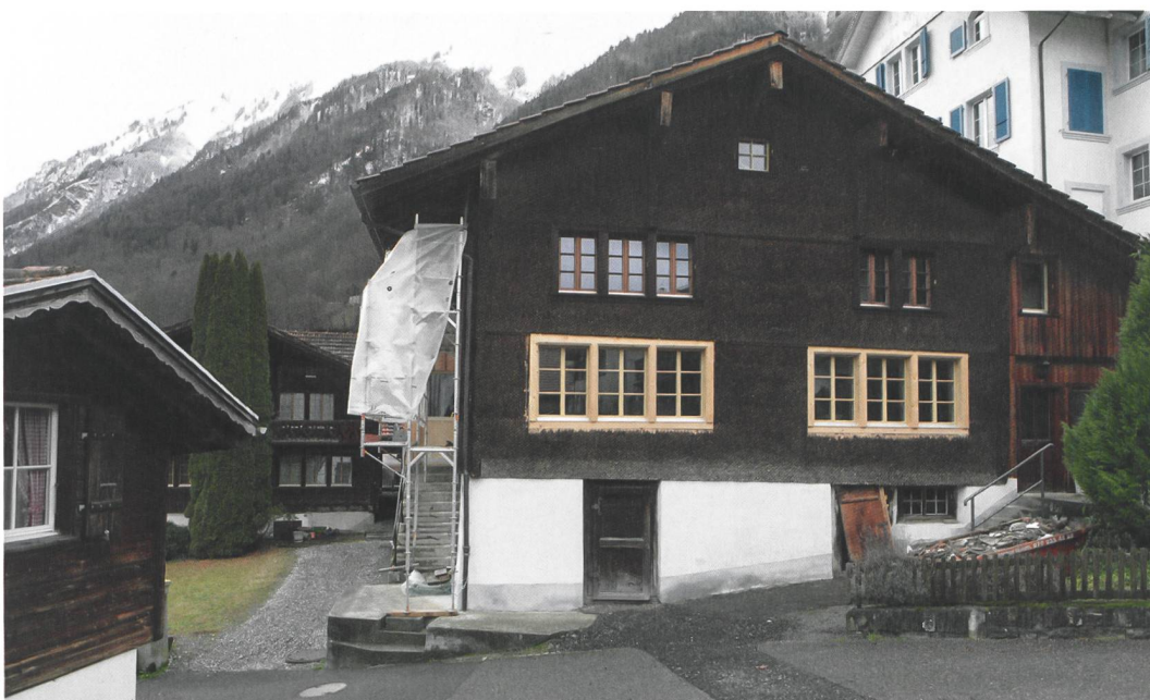
Abb. 1: Oberried, Untergasse 9. Hinter der verschindelten Fassade schlummerte unerkannt ein altes Haus. Blick nach Westen.
