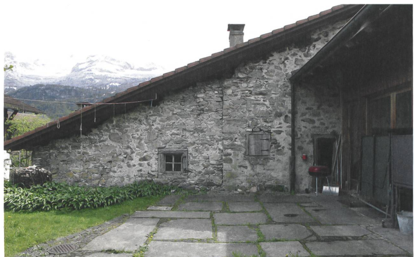
Abb. 2: Brienz, Oberdorfstrasse 92. Hofseite des östlichen Hausteils mit dem gemauerten Küchen- und Gewerbetrakt. Eine Baunaht deutet die östliche Erweiterung an. Rechts schliesst der moderne Trakt der Geigenbauschule an (Oberdorfstrasse 94). Blick nach Süden.
