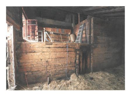
Abb. 7: Adelboden, Hirzbodenportstrasse 10. Blick in den Ökonomiebereich. Gut erkennbar ist die geschlossene Wohnkiste (rechts) sowie der der Ökonomie zugeschlagene Raum oberhalb der Küchenkammer. In der Bildmitte führt die Türe durch den Verbindungsgang zum Wohntrakt. Blick nach Süden.
