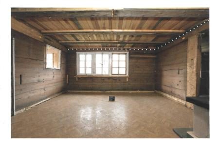
Abb. 4 (links): Adelboden, Hirzbodenportstrasse 10. Die Gadenzimmer übernahmen die räumliche Einteilung des Stubengeschosses. Erschlossen wurden sie über die einst offene Rauchküche. Über der Küchenkammer befand sich bis zuletzt der Heuboden. M. 1:150.
