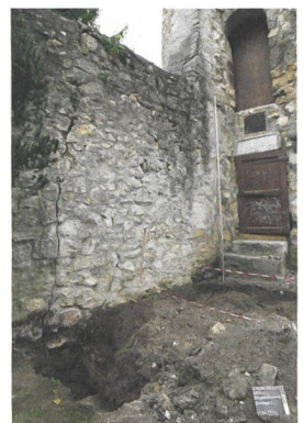
73 Nidau, Strandweg 2, Ziegelhütenturm
