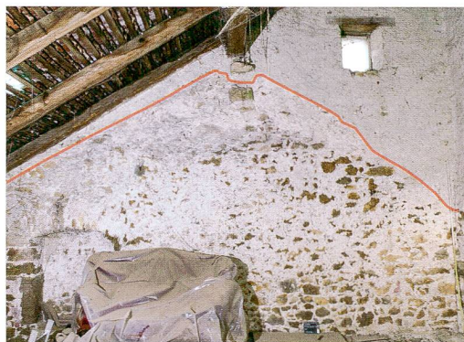
Abb. 3: Twann-Tüscherz, Dorfasse 9c. Nordmauer mit Abdruck des ursprünglichen Daches (rote Linie); in der Ecke links unten, das ursprüngliche Fenster (31).
