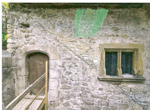
Abb. 4: Twann-Tüscherz, Dorfasse 9c. Westfassade mit Bogenportal zum spätmittelalterlichen Primärbau. Kamin- und Fenstereinbau (grün) stammen aus dem späten 17. Jahrhundert.
