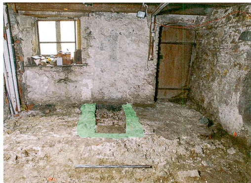
Abb. 5: Twann-Tüscherz, Dorfasse 9c. Erdgeschoss mit Kachelofenfundament (grün). Rechts, die ursprüngliche Tür; links, das Doppelfenster aus dem späten 17. Jahrhundert.
