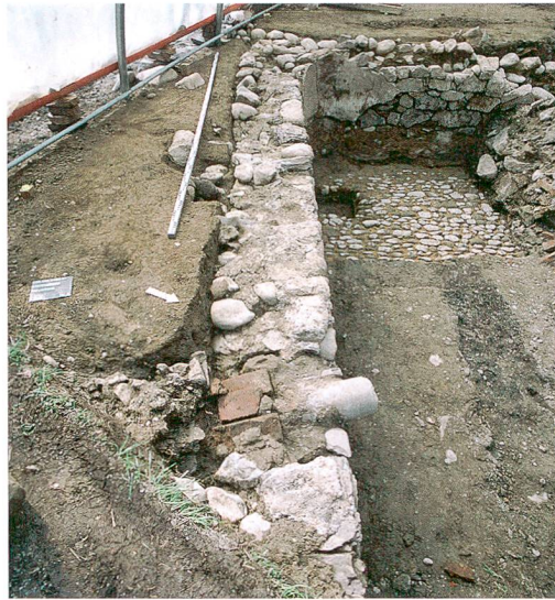
Abb. 6: Steffisburg, Bernstrasse 107/111. Südwand des beckenartigen Baus westlich vom Waisenhaus mit Pflasterung und nachträglich eingebautem Wassereinlauf im Vordergrund im Jahr 2005. Blick nach Südwesten.
