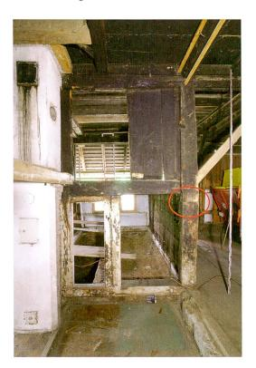
Abb. 3: Lützelflüh, Moosmatt 727a. Die zweigeschossigen Eckständer wurden aus jeweils zwei Hölzern errichtet. Diese aufeinandergestellten Ständer sind nicht kraftschlüssig und zeigen daher einen deutlichen Verzug. Blick nach Nordosten.
