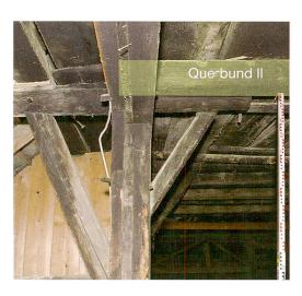
wie üblich kraftschlüssig auf Tragwände übertragen und bis auf die Erde abgeleitet wird. Vielfach sind die tragenden Wände um einige Zentimeter verschoben. In einigen Fällen wurden extra Hölzer eingebaut, um die konstruktiven Mängel zu beheben (Abb. 4). Sogar das Dachwerk war einst anders zusammengesetzt, wie leere Zapflöcher im First und Blattsassen im Unterfirst belegen.
