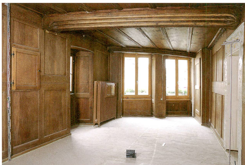
Fig. 7: La Neuveville, Grand Rue 15. Bâtiment B, 1 er étage. Belle pièce richement boisée comportant un plafond et des solives ouvragées du 16 e siècle, ainsi qu'une paroi en chêne du 18 e siècle.
