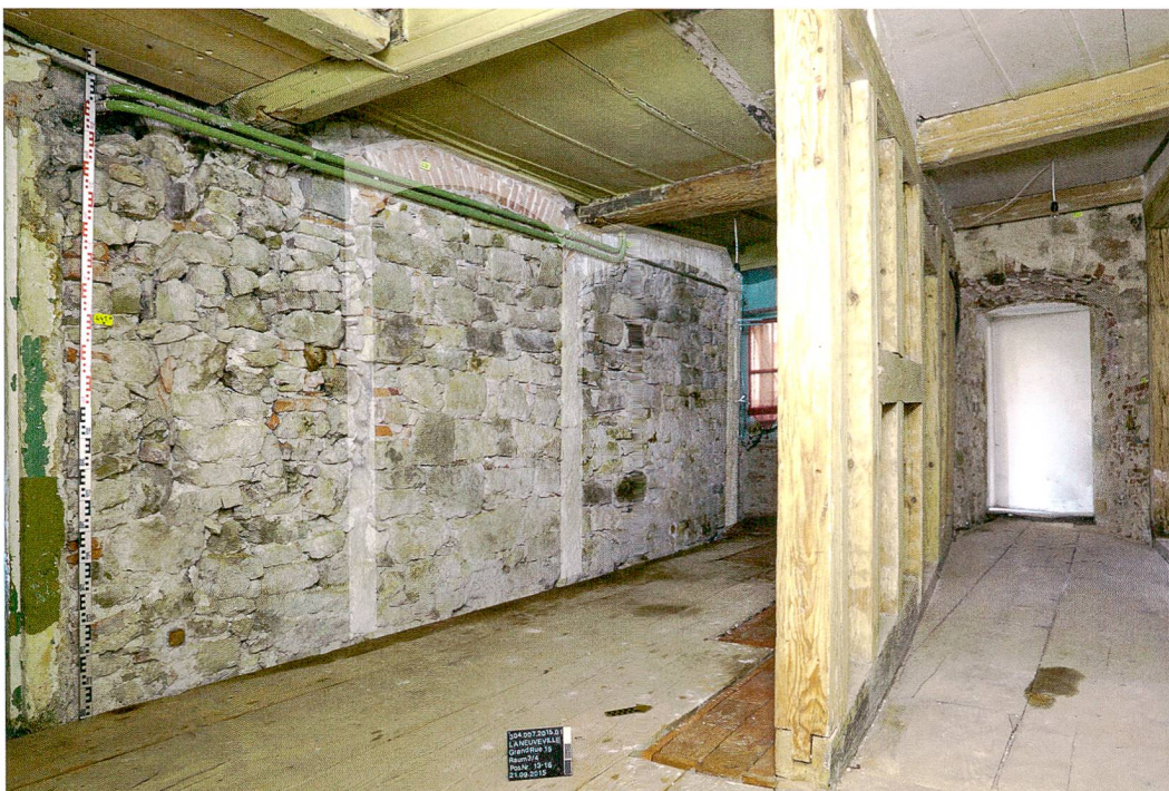
Fig. 9 : La Neuveville, Grand Rue 15. Bâtiment B, 1 er étage. À droite, le couloir, une des cloisons en pan de bois et la porte de sortie nord ; à gauche, la chambre et les deux niches murales rebou-chées ultérieurement. Au fond, se trouvaient les latrines. Vue vers l'ouest.
