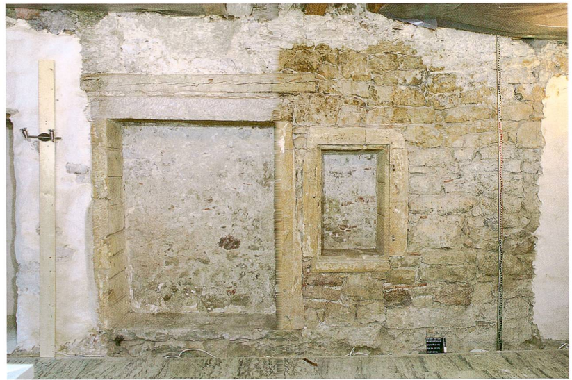
Fig. 3 : La Neuveville, Grand Rue 15. Bâtiment A, rez-de-chaussée. Grandes niches murales à encadrements en pierre de taille. Vue vers l'ouest.
