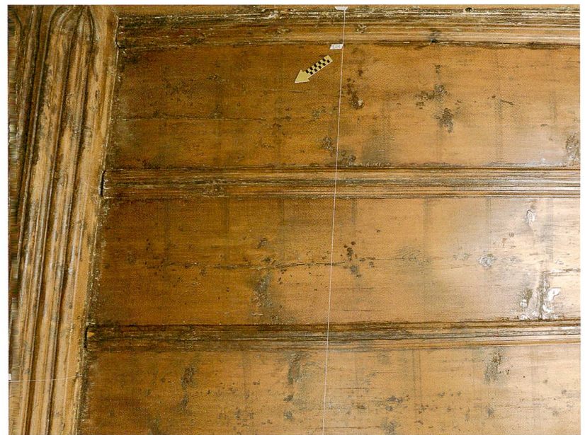
Fig. 8 : La Neuveville, Grand Rue 15. Bâtiment B, 1 er étage. Détail du plafond à couvre-joints orné d'un décor de bandes formées de lignes incisées datant du début du 16 e siècle.
