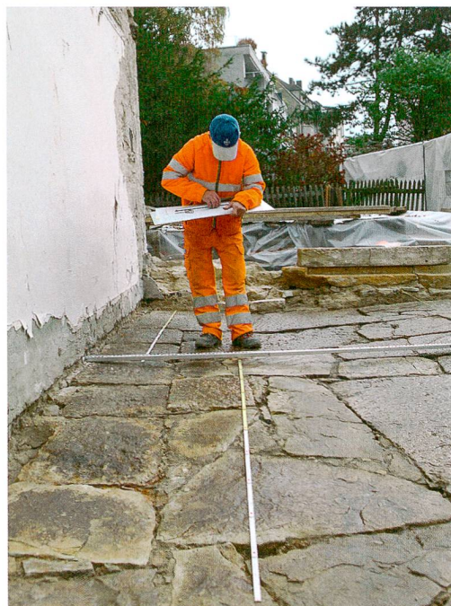
Fig. 4 : Bienne, rue Karl-Neuhaus 3. Relevé du dallage calcaire apparu au niveau de l'annexe sud, érigée après 1846 et démolie en 2016.
