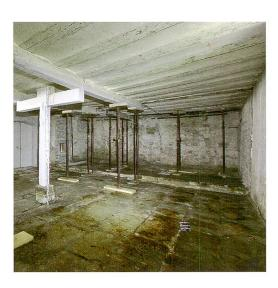
Fig. 2: Bienne, rue Karl-Neuhaus 3. Le rez-dechaussée se composait de deux pièces, dont le sol était couvert d'un magnifique dallage calcaire. Le solide solivage à voutain du plafond est aussi d'origine. Vue vers le nord.
