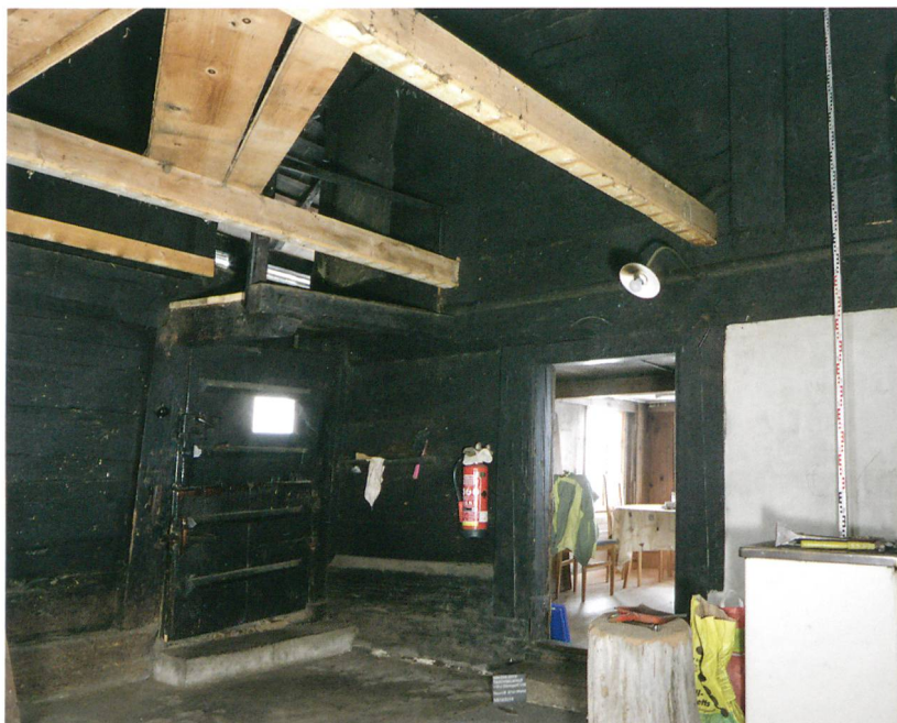
Abb. 4: Trachselwald, Vorder Giselgut 146. Rauchküche. Das Podest über der Haustüre und die Türe zur Laube sind erhalten. Die Türe in die Stube wurde nach Süden verschoben, dies geschah wohl beim Bau der neuen Mauer und der Veränderung der Herdstelle. Blick nach Südwesten.
