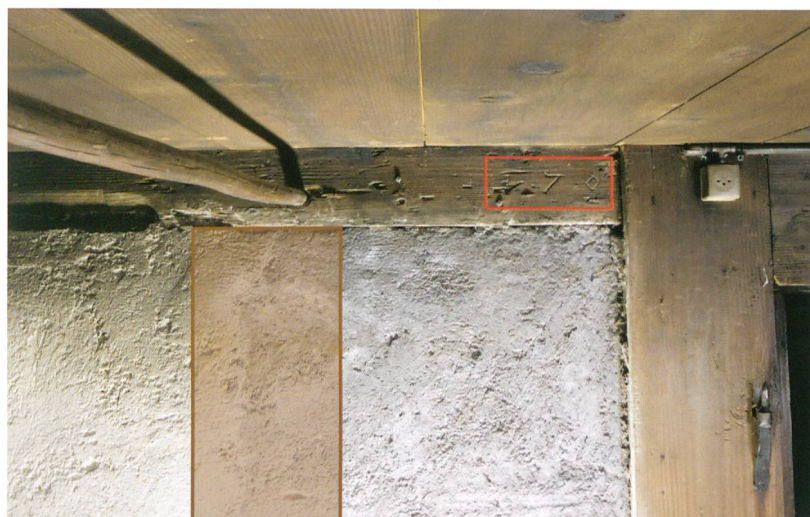
Abb. 2: Trachselwald, Vorder Giselguet 146. Ehemals lag die Verbindungstüre zwischen Stube und Küche stärker im Norden, dies ist noch an der Fasse mit Abwurf im Rähm zu erkennen. Braun eingefärbt wurde die ungefähre Lage des Türständers. Mittig über dieser ehemaligen Stubentür ist die Jahreszahl eingeschnitten, zu lesen sind noch die Zahlen «170...» (rotes Viereck). Blick nach Osten.
