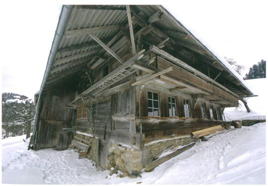
Abb. 1: Trachselwald, Vorder Giselguet 146. Die starke Hanglage ist gut zu erkennen. In der Nordfassade zeigt sich die Kellertüre, über dem gemauerten Sockel liegt der mächtige Schwellenkranz mit Zapfenschloss. Nordseitig in der Ecke ist das mit Brettern verschlossene letzte originale Fenster zu sehen. Blick nach Südosten
