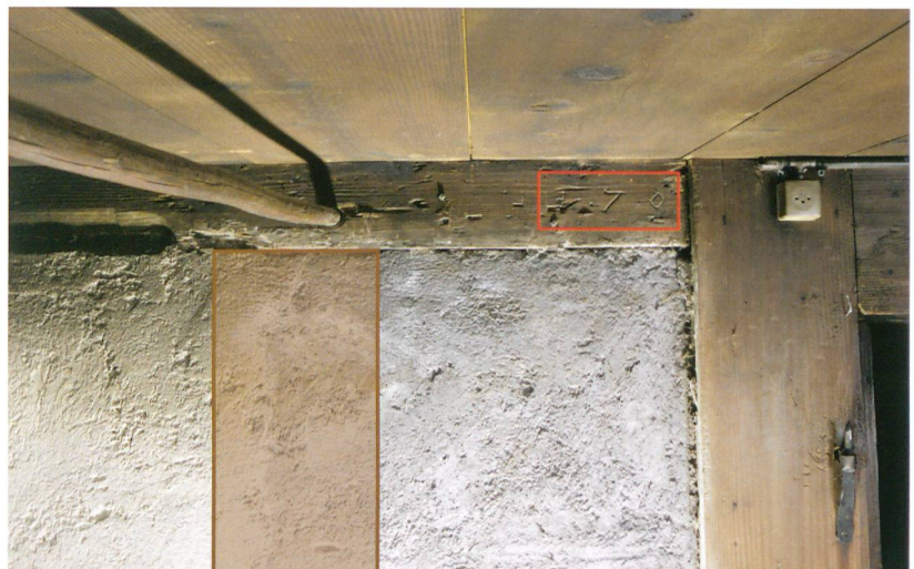
Abb. 2: Trachselwald, Vorder Giselguet 146. Ehemals lag die Verbindungstüre zwischen Stube und Küche stärker im Norden, dies ist noch an der Fase mit Abwurf im Rähm zu erkennen. Braun eingefärbt wurde die ungefähre Lage des Türständers. Mittig über dieser ehemaligen Stubentür ist die Jahreszahl eingeschnitten, zu lesen sind noch die Zahlen «170..» (rotes Viereck). Blick nach Osten.
