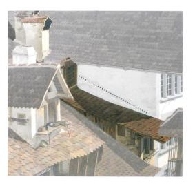
Abb. 4: Thun, Obere Hauptgasse 75. Der Ausschnitt aus dem Thun-Panorama von Marquard Wocher zeigt die Häuser Nr. 77 (rechts oben) und Nr. 75 (links daneben) im Zustand des frühen 19 Jahrhunderts Die Punktlinie markiert den Abdruck des älteren Daches.
