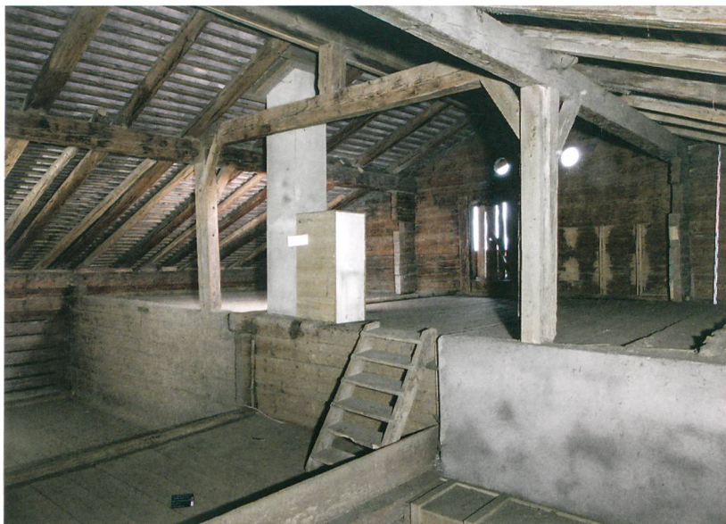
Abb. 6: Thun, Goldiwil, Matthausweg 23. Dachraum hinter der Giebelwand mit stehender Dachstuhlkonstruktion. Links im Bild ist die Gimmwand mit der Gadenwand überkämmt. Blick nach Südwesten.
