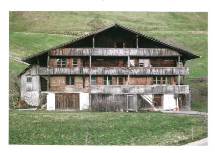
Abb. 3: Thun, Goldiwil, Matthausweg 23. Die Blockkonsolen im Giebelfeld sind mit zeittypischen Einschnitten und Abfasungen verziert. Auf dem Sturzholz der Türe zur Bühnislaube befindet sich die Bauinschrift «1614 VLI RÄBER». Blick nach Süden.
