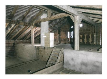
Abb. 6: Thun, Goldiwil, Matthausweg 23. Dachraum hinter der Giebelwand mit stehender Dachstuhlkonstruktion. Links im Bild ist die Gimmwand mit der Gadenwand überkämmt. Blick nach Südwesten.
