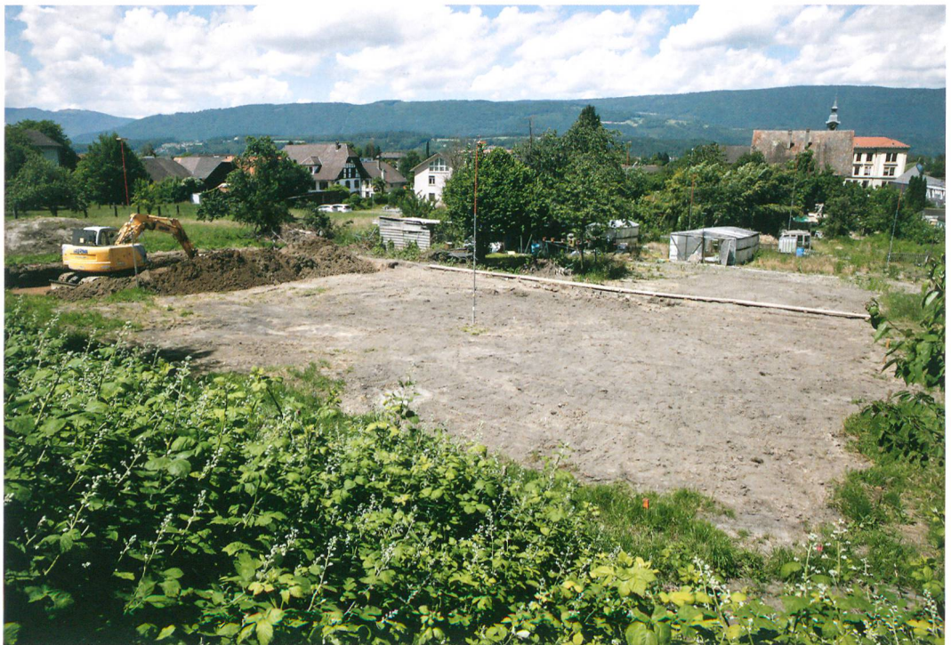
Abb. 1: Büren an der Aare, Aarbergstrasse 5, 7, 9. Grabungssituation. Blick nach Nordwesten.
