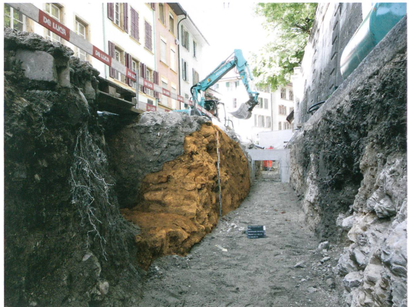
Fig. 4: Bienne, rue Basse. À gauche, quasi au milieu de la chaussée, les fondations de l'ancien mur de soutènement de l'esplanade de l'église; en haut à droite, le mur actuel édifié vers 1841. Vue vers le sud-est.
