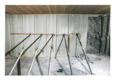
Abb. 3: Biel, Obergasse 13. Die Täferung der nordöstlichen Stubenwand im ersten Obergeschoss verhinderte das Ausbrechen der Füllung der Wandnische.
