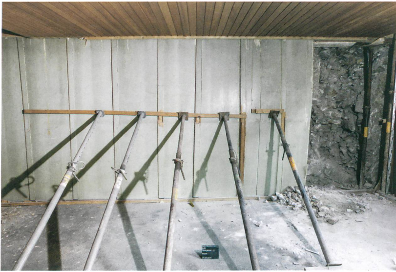
Abb. 3: Biel, Obergasse 13. Die Täferung der nordöstlichen Stubenwand im ersten Obergeschoss verhinderte das Ausbrechen der Füllung der Wandnische.
