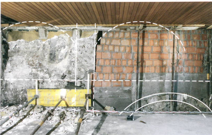
Abb. 4: Biel, Obergasse 13. Die nordöstliche Stubenwand im ersten Obergeschoss mit dem Laubenbogen, dem Wandpfeiler und den rekonstruierten Wandnischen.
