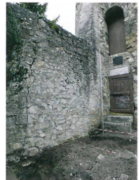
70 Nidau, Strandweg 2, Ziegelhütenturm
