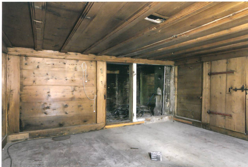
Abb. 3: Saanen-Gstaad, Litzistrasse 21. Die Stuben sind als Bohlen-Ständerkonstruktion errichtet. Alle vorkragenden Elemente sind durch eine Profilierung betont, die sich auch an den Balken der Decke finden. Blick nach Osten.
