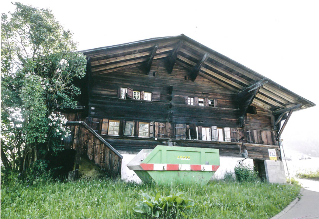
Abb. 1: Saanen-Gstaad, Litzistrasse 21. Die westliche Hauptfassade des Bauernhauses war ursprünglich schmaler. Die ehemaligen Seitenlauben sind nachträglich zu Räumen ausgebaut worden. Zur Bauzeit führten noch beidseitig Treppenaufgänge zu den Seitenlauben. Blick nach Osten.
