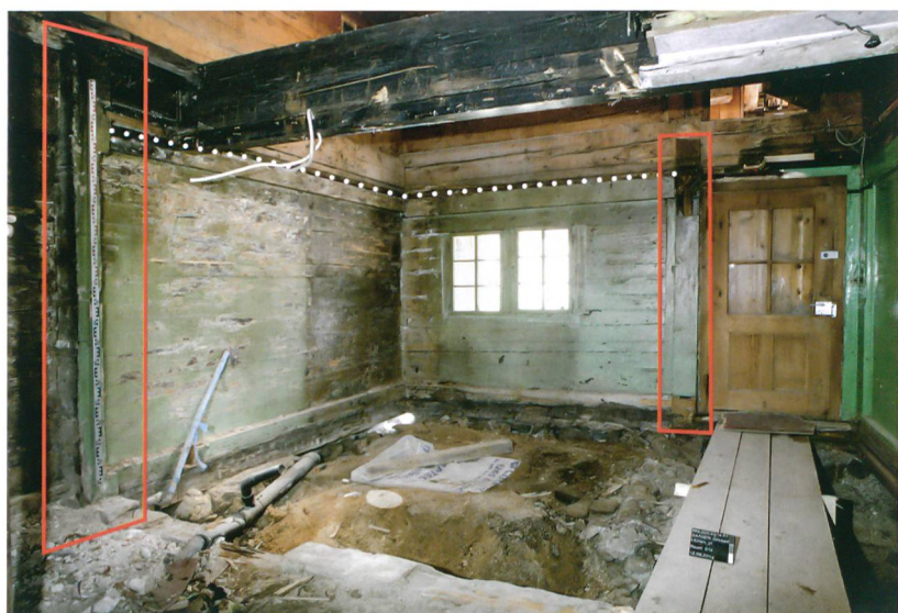
Abb. 4: Saanen-Gstaad, Litzistrasse 21. In der Südostecke befand sich einst eine Küchenstube. Ihre Ausdehnung ist anhand der Deckennut (weisse Punkte) und der beiden zurückgesägten Blockverbände (rot eingrahmt) abzulesen. Blick nach Südosten.
