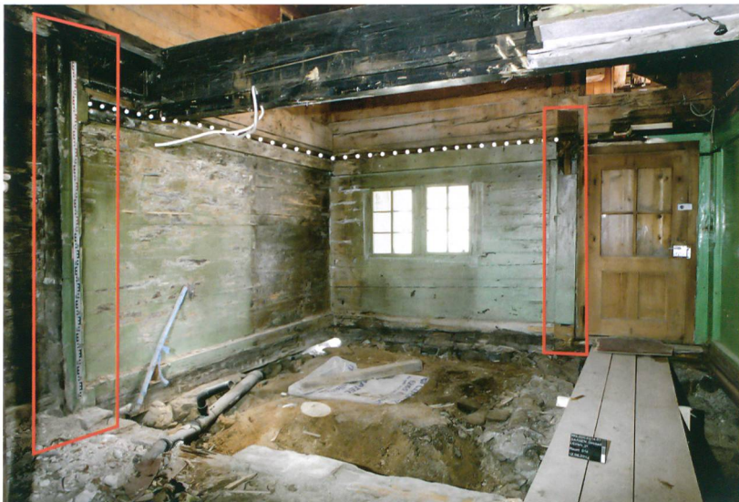
Abb. 4: Saanen-Gstaad, Litzistrasse 21. In der Südostecke befand sich einst eine Küchenstube. Ihre Ausdehnung ist anhand der Deckennut (weisse Punkte) und der beiden zurückgesägten Blockverbände (rot eingeraht) abzulesen. Blick nach Südosten.
